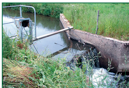
Barrage à clapet sur l'Araize
