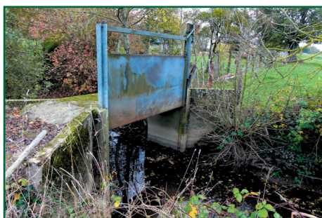
Barrage à vannes levantes sur l'Hommée
