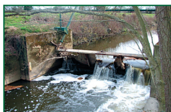
Clapet percé sur l'Argos
